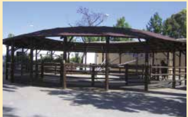
Cubierta caminador madera.
