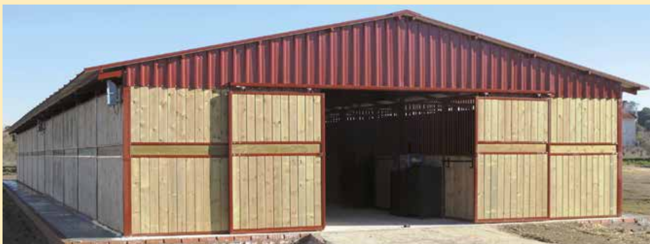
Nave americana cubierta chapa sándwich o pre-lacada.
