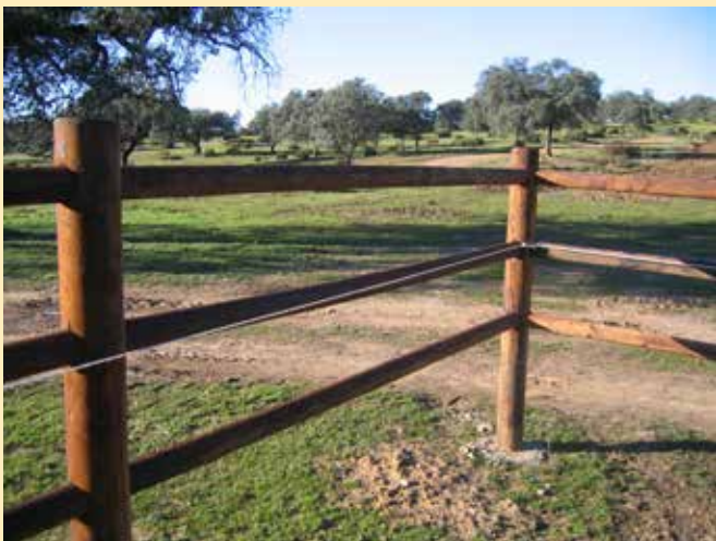
Vallado encastrado creosotado.
