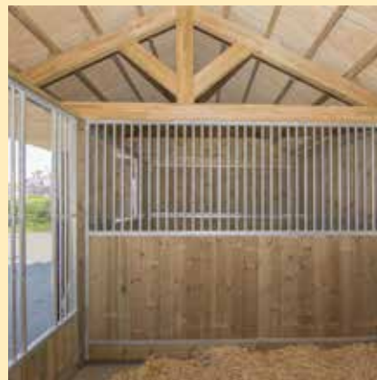
Cubierta Bandana vista interior.
