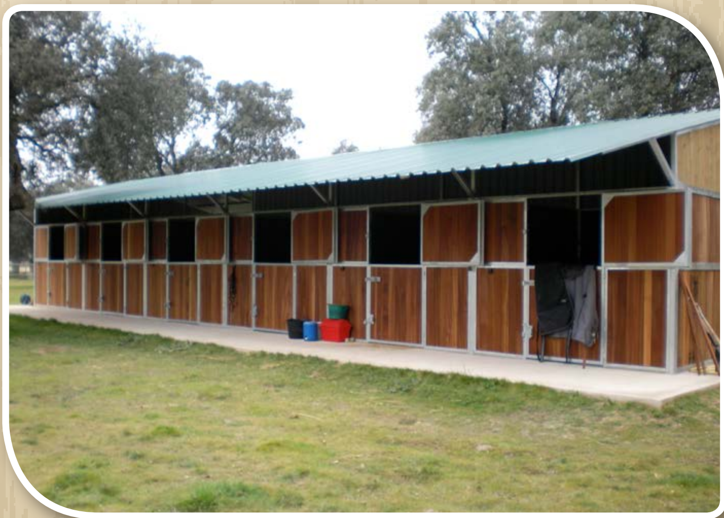
Frontal Box Exterior. Galvanizado. Nave Boxes Espalda/Espalda.
